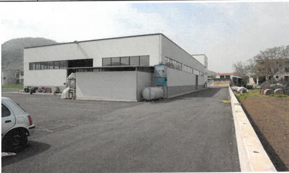
Figura 4 Veduta esterna dell'opificio dalla parte posteriore. È altresì evidente l'impianto di riciclo dell'acqua di processo ed il locale ove si trova l'impianto di condensazione e recupero dell'acetone.
