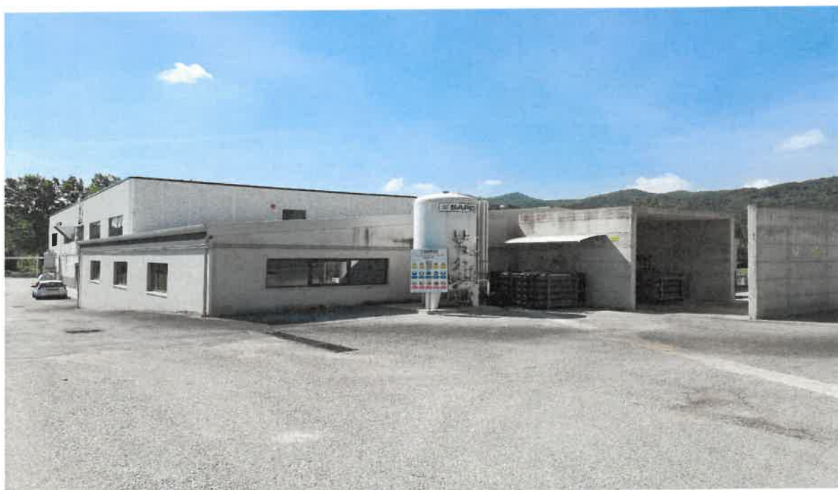
Figura 5 Nuovo capannone, veduta laboratorio e deposito idrogeno
