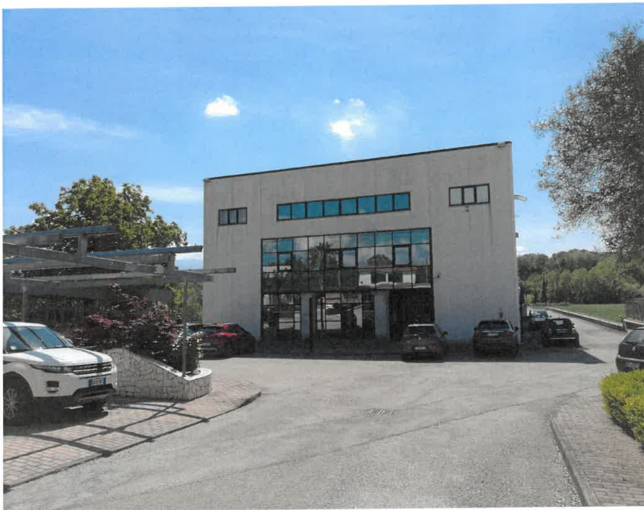
Figura 3 Veduta esterna dell'opificio dalla parte frontale con l'ingresso agli uffici che sono ubicati al primo piano della stabile
